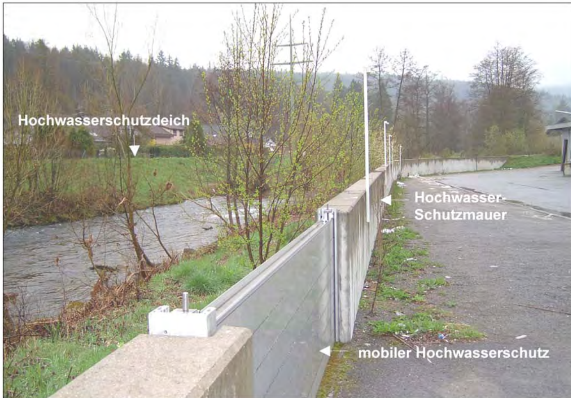
Bild 5: Beispiele für lokale Hochwasserschutzmaßnahmen
