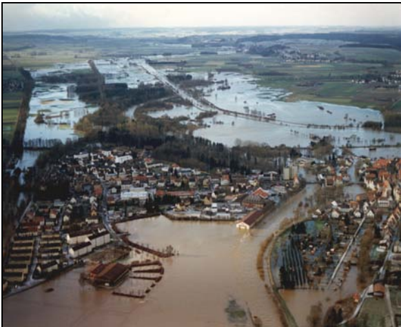
Abb. Z-4: Hochwasser im Februar 1990 an der Donau bei Riedlingen
